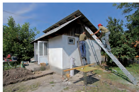
Workcamp-Einsatz in Rumänien: Mit Pickel und Schaufel hoben wir etwa 200 Meter Gräben aus und verlegten Sickerleitungen. Darüber hinaus wurde das Dach beim Toiletten-Gebäude fertig gestellt.
